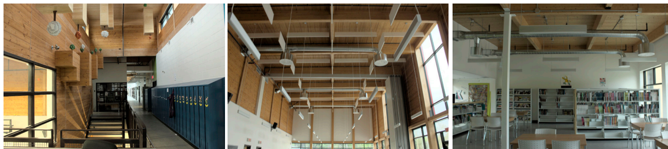
Imagen 1. Pasillo, sala multifuncional y aulas que integran madera en su superficie (fuente: Archivo de los autores).
