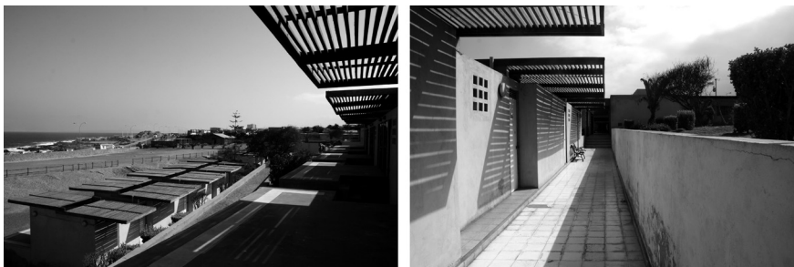
Imagen 2. Casa de Retiro del Colegio San Luis (Fundación Alonso Ovalle), Antofagasta (fuente: Los autores, 2014).
