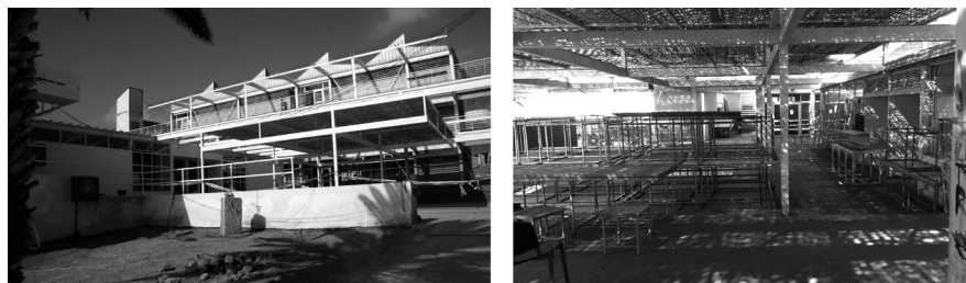
Imagen 3. Patios y cubiertas de la Escuela de Arquitectura de la Universidad Católica del Norte, en Antofagasta (fuente: Los autores, 2014).
