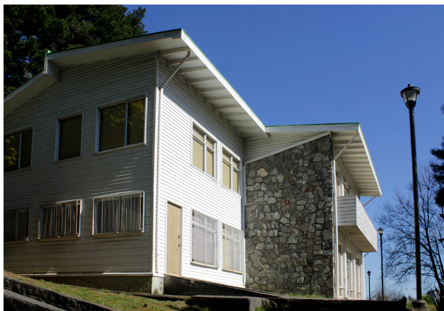
Imagen 3. La Cabina 6, ampliada con un segundo piso que alteró la estructura de techumbre, es el caso de intervención más invasiva (fuente: Del autor, 2021).
