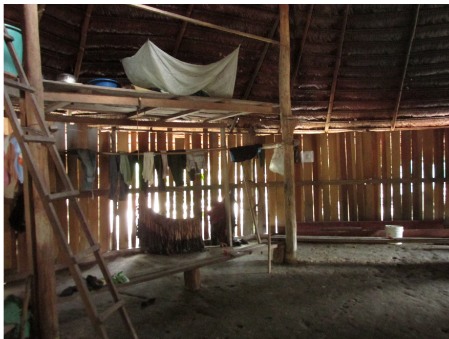
Imagen 6. Interior de la maloca (fuente: Del autor, 2016).
