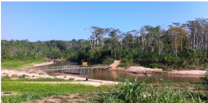
Imagen 2. Registro fotográfico del puente construido que atraviesa el Río Gregorio en la aldea Mutum conectando redes de caminos forestales (fuente: Mendo, 2016).
