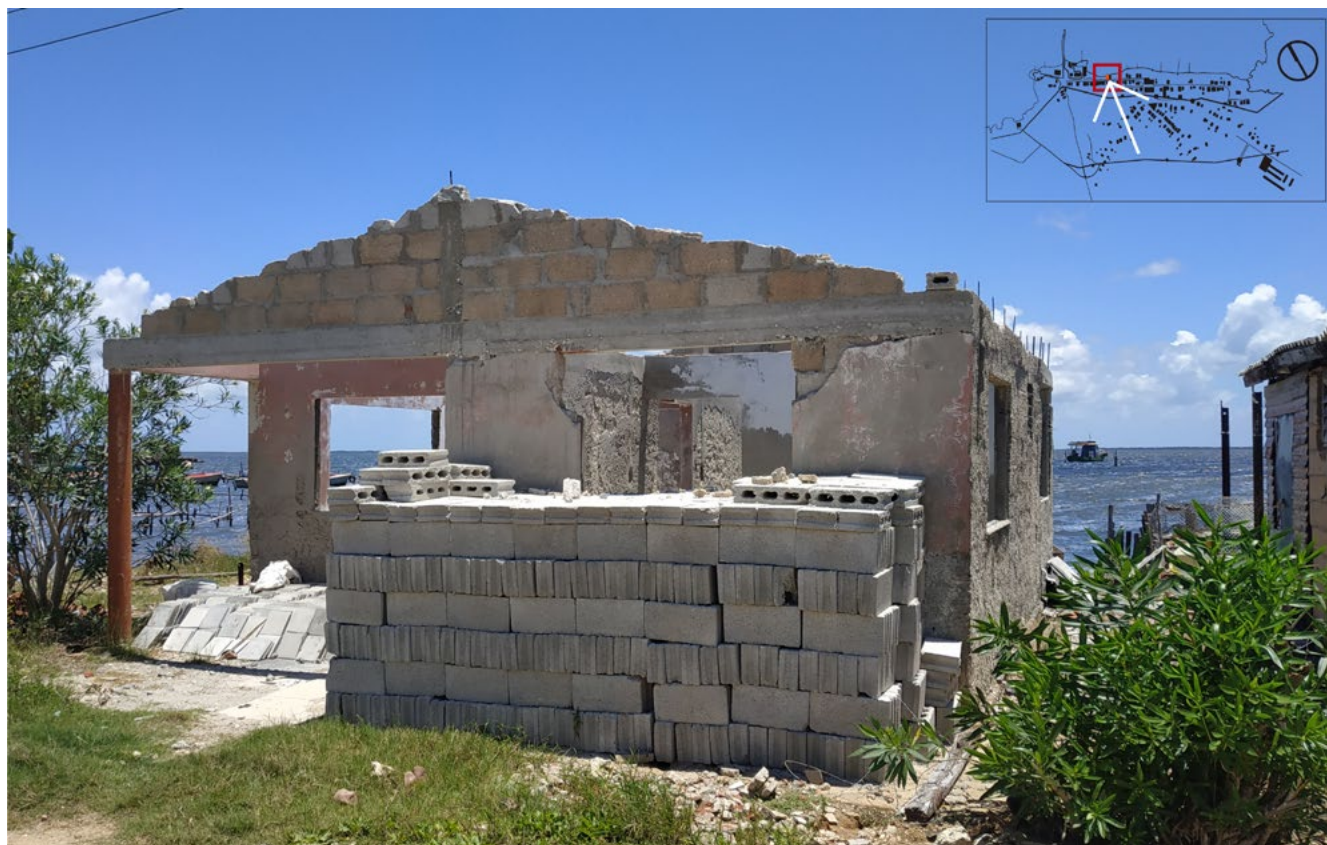
Imagen 5. Vivienda que clasifica como “derrumbe parcial” siendo reparada con materiales duraderos sobre la línea de costa (fuente: González-Camacho, 2019).
