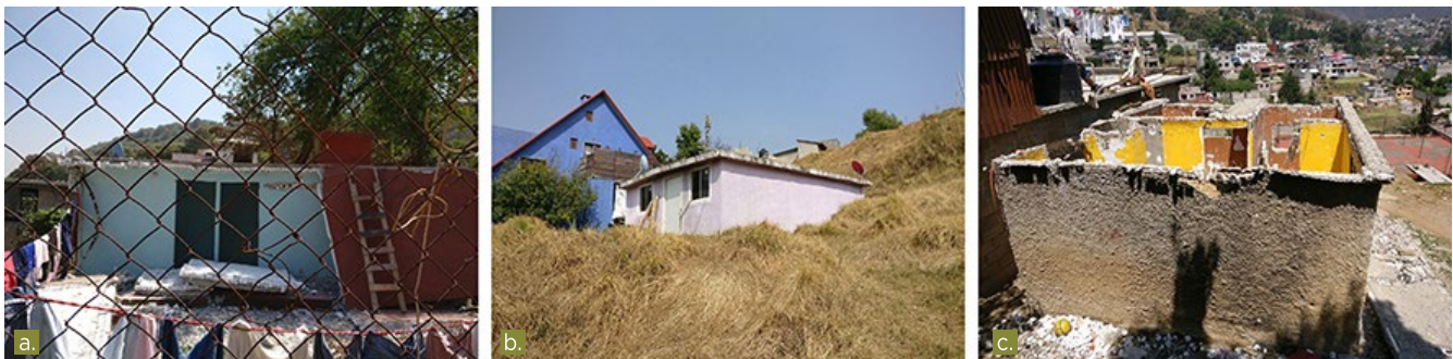
Imagen 1. Casas del “Programa A” de donación de vivienda en Huixquilucan. a / Retiro de muros interiores de la vivienda por parte de sus habitantes. b / Vivienda abandonada. c / Vivienda en proceso de demolición (fuente: Elaboración propia, 2018).
