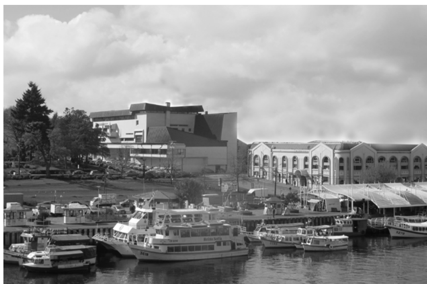
Imagen 4. Situación del edificio original a partir de la intervención de una fotografía actual (fuente: La autora, 2019).
