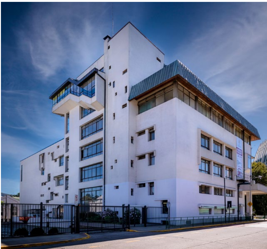
Imagen 7. Caja de escala y fachada sur (fuente: Archivo Revista AUS. Fotografía Abel Lagos, 2021).
