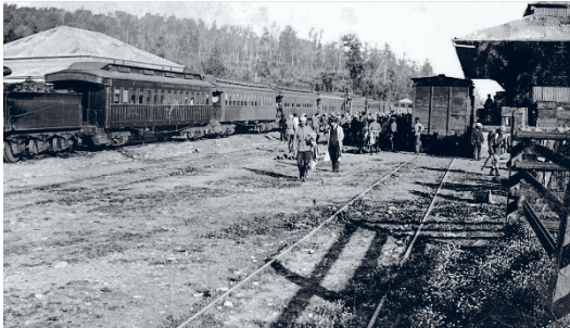
Figura 13. Estación de Collipulli.
